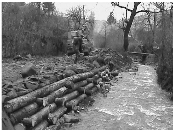
Рис. 6. Типова конструкція зрубової стінки.
