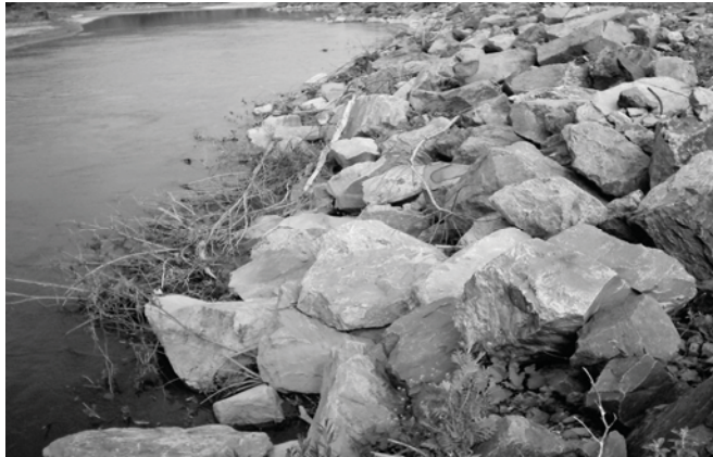
Рис.1. Загальний вигляд кріплення – кам'яний накид
