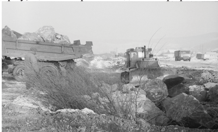
Рис.2. Роботи по обладнанню кріплення берегової лінії р.Тиса поблизу смт. Королево Виноградівського району Закарпатської області –кам'яна призма.
