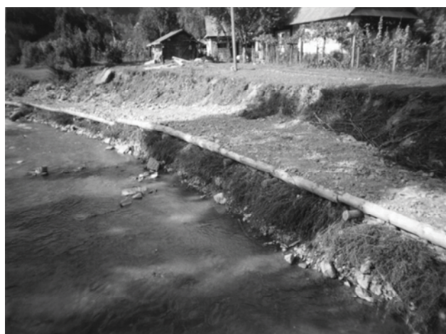
Рис.7. Вдосконалена конструкція зрубової стінки.
