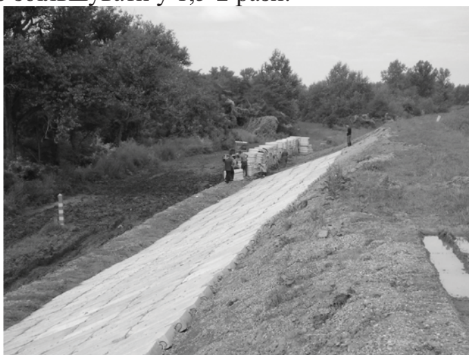
Рис. 5. Кріплення залізобетонними плитами
