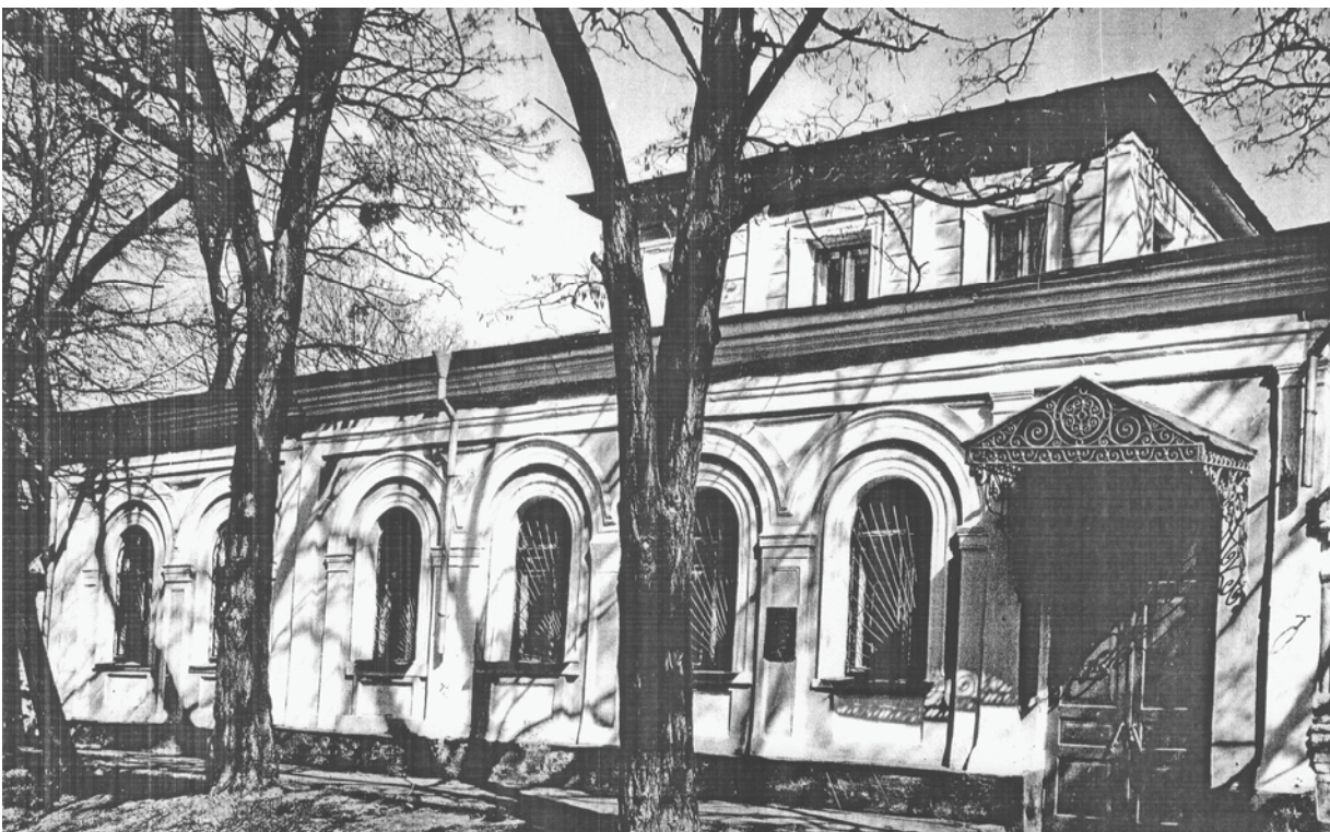
Рис. 2. Будинок Київської метеорологічної обсерваторії вул. Толстого 14-б **
