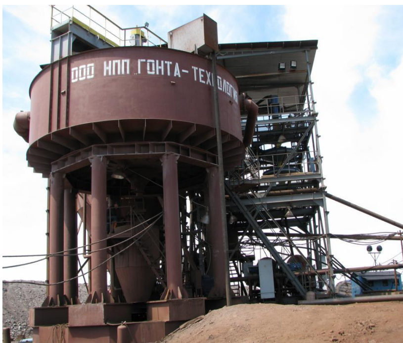
Рис. 10. Общий вид установки предприятия «Гонта-Технология» по производству концентрата лежалых металлургических шламов комбината «АрселорМиттал Кривой Рог».
