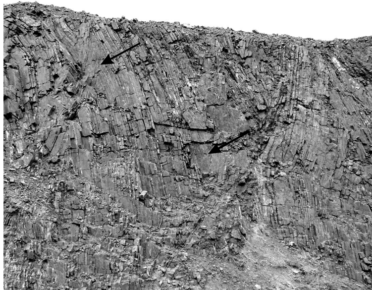
Рис. 2. Проявление изгиба осевых поверхностей складок. Карьер ЮГОКа, северный борт, горизонт -15м. Высота стенки забоя около 15 м.
