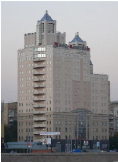
Рис. 9. Здание ИДФ банка при естественном освещении. Краснопресненская набережная № 6, г. Москва.
