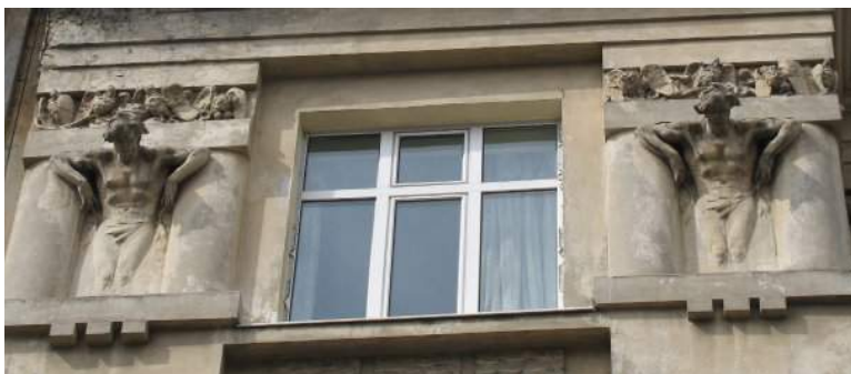
Рис. 5. Будинок по вул. Чупринки, 6
