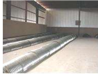
Рисунок 5 – Камера с системой активного вентилирования при хранении овощей насыпью
