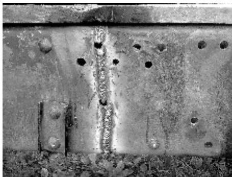
Рисунок 11 — Заварювання тріщини.
