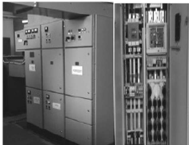
Рисунок 3 — Шафа засобів автоматизації
