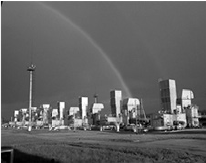
Рисунок 1 — Укриття газоперекачувального агрегата
