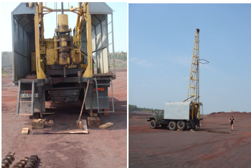
Рис. 2. Разбуривание западного резервного склада самоходной буровой установкой УКБ-500
