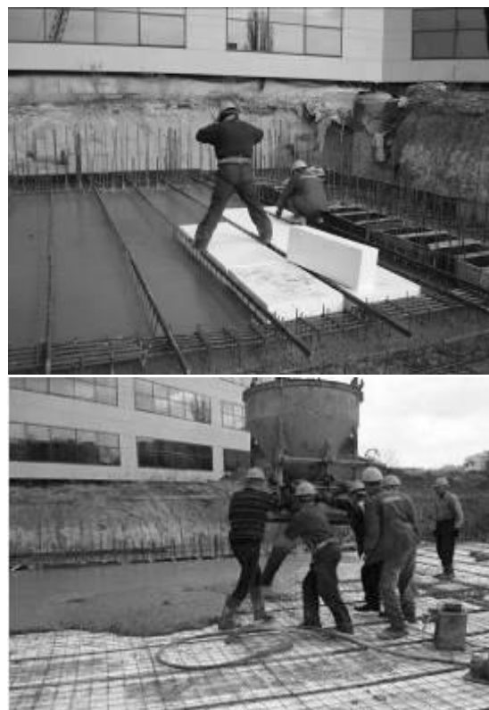
Рис. 2.4. Последовательность возведения эффективного перекрытия.
