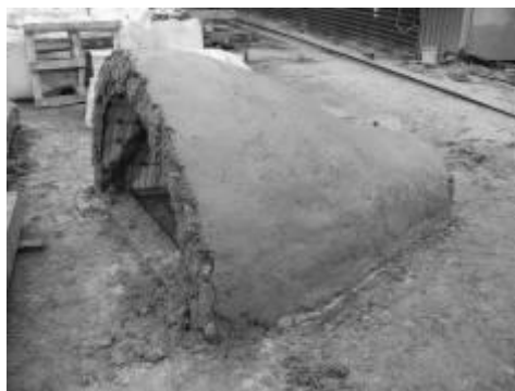
Рис. 2.6. Безопалубочное бетонирование методом торкретирования (окончание).
