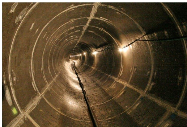
Рис. 2. Восстановленный участок Ново-Люберецкого канала [10]
