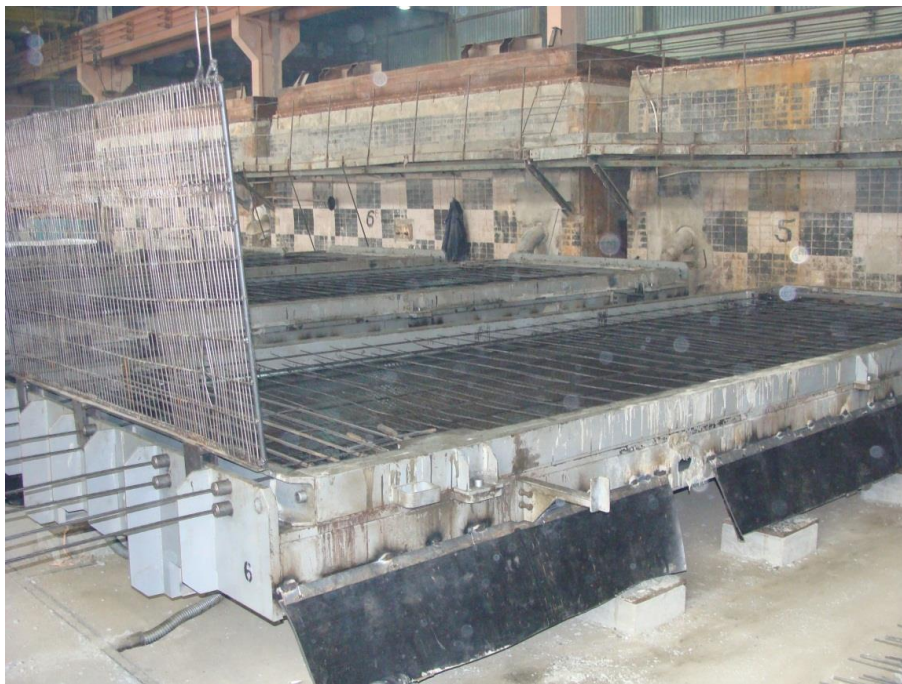
Рис. 3. Опалубка и армирование плиты ПДН-14
