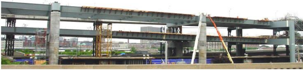
Рис. 14. Эстакада после завершения монтажа.
