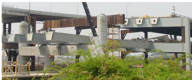
Рис.10. Первый пролет эстакады. Смонтирован настил нижнего уровня.
