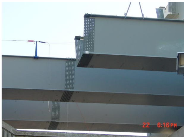
Рис. 11. Стыки балок настила нижнего уровня.
