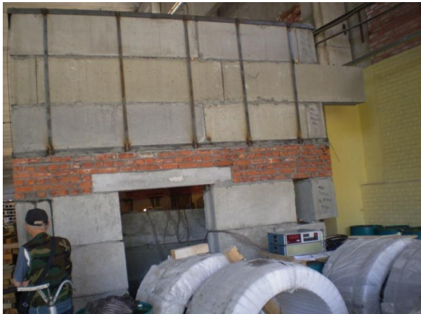
Рис.3. Общий вид фрагмента перекрытия с нагрузочной ванной
