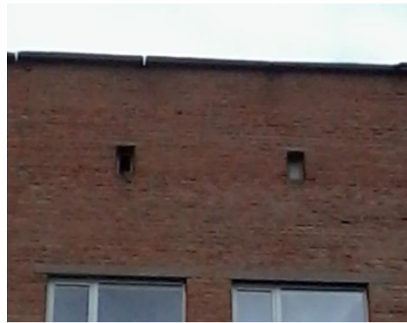
Рис. 7. Вентиляційні отвори холодного горища
