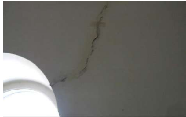
Рис.3.Вертикальная трещина в кирпичной кладке стены
