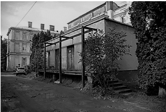
Рис. 10. Наявна на території комплексу трансформаторна (фото Р. Колісник)
