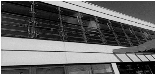
Рис. 2. Сонячна установка компанії Геліатек [8]
