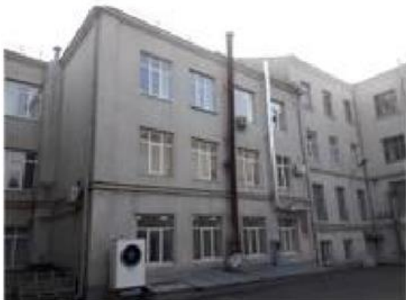
Рис. 1. Натурний об'єкт для дослідження ефективності споживання тепла
