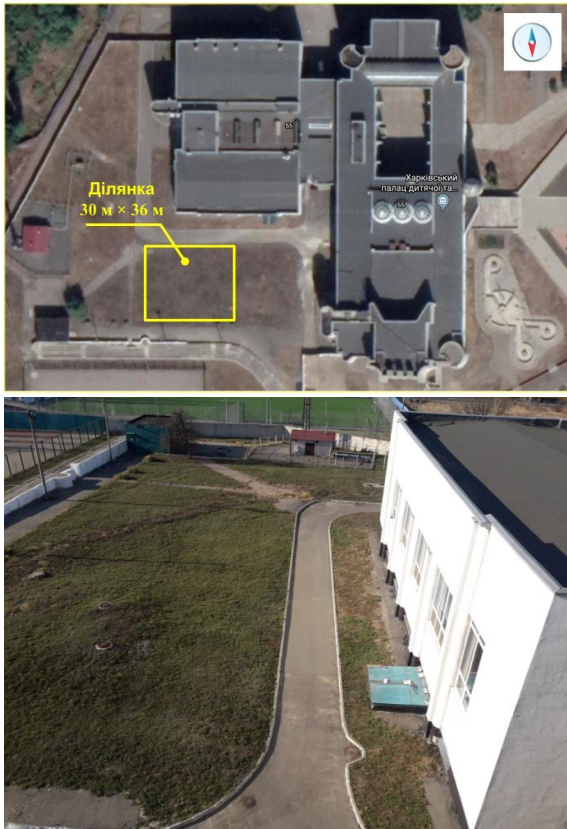
Рис. 2. Загальний вигляд місця можливого розташування геліосистеми
