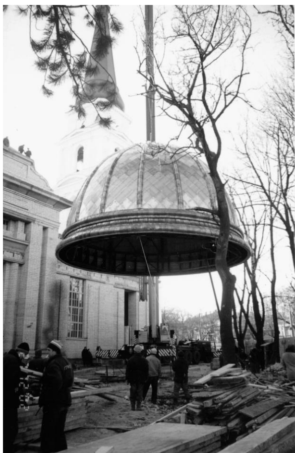
Рис. 9. Монтаж малого зовнішнього куполу
