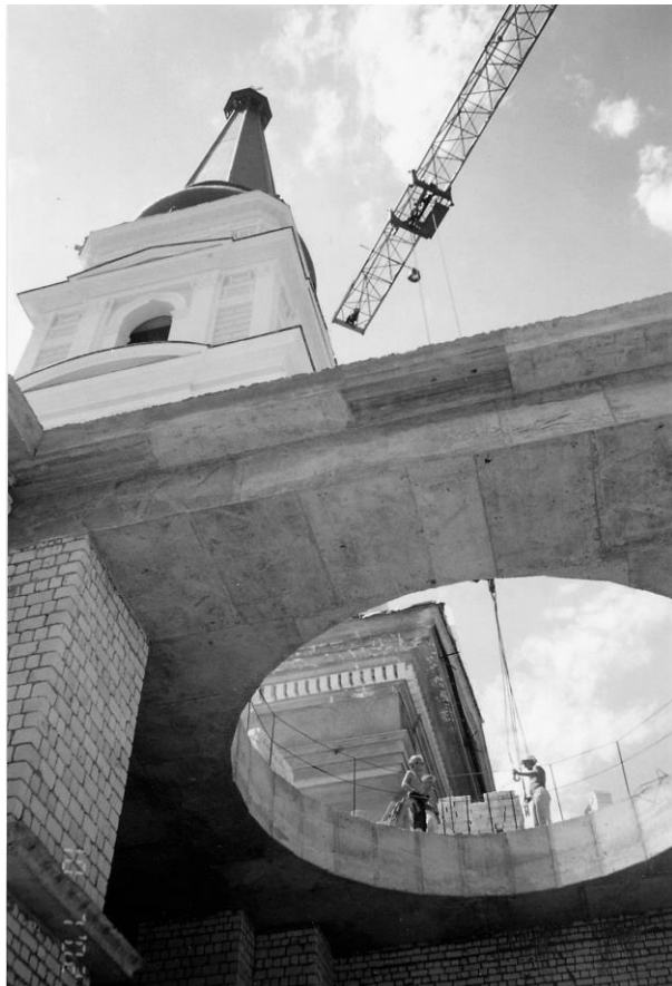
Рис. 5 Монолітна залізобетонна плита під купол
