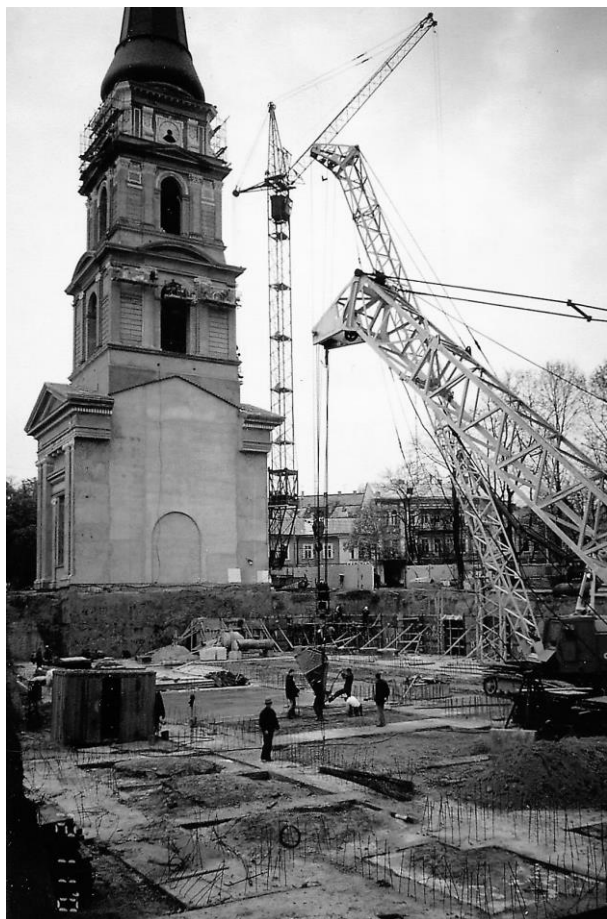
Рис. 2 Влаштування фундаментів Собору
