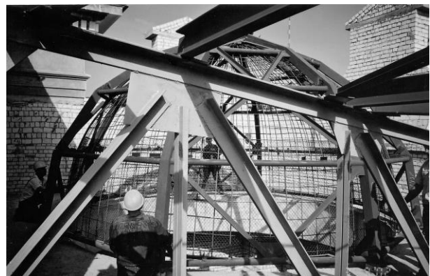
Рис. 7 Металеві конструкції покриття
