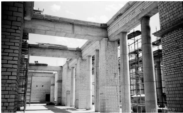
Рис. 4 Конструктивні рішення будівлі Собору
