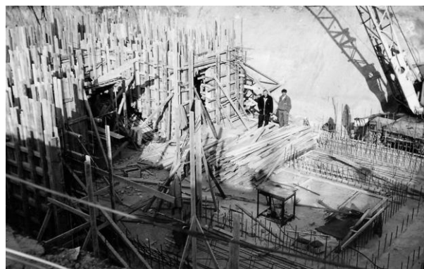
Рис. 3 Опалубка для бетонування стін підземної частини дзвіниці
