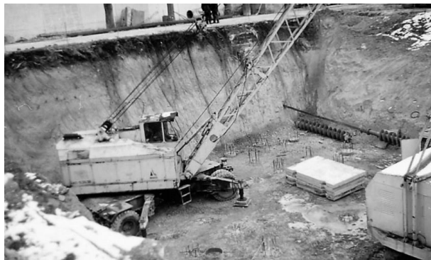
Рис. 1 Влаштування фундаментів дзвіниці
