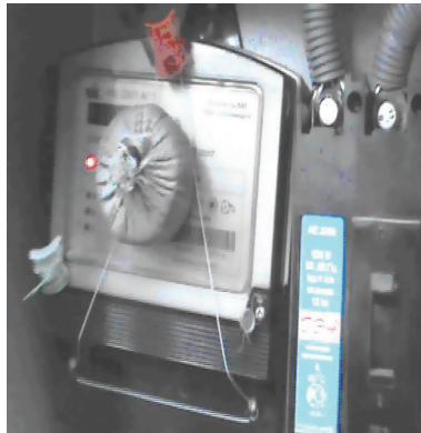
Рис. 2. Електронно-механічний лічильник із встановленим на ньому магнітом для безоблікового споживання електроенергії
