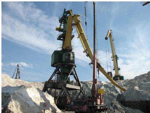
Рис. 1. Втомне руйнування ділянки металоконструкції стріли п/к «Альбатрос»
