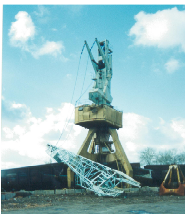
Рис. 2. Втомне руйнування металу стріли КППГ 5-30
