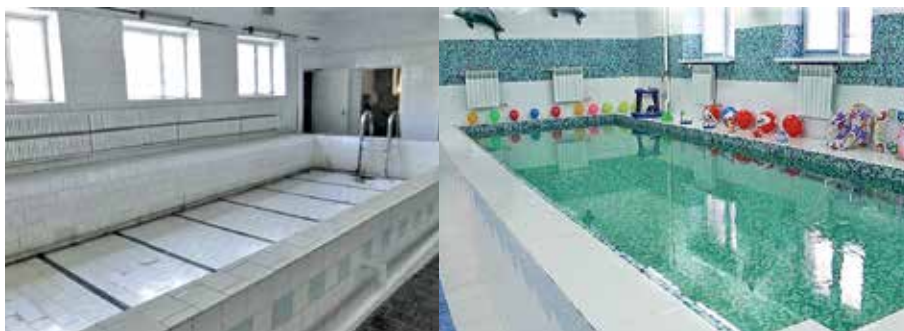
Стан басейну до ремонту і після ремонту
