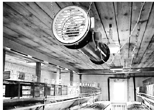
Рис. 2. УФБ рециркулятор повітря тваринницьких приміщень РПБ 1,8-6/30 оз:
