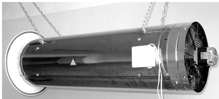
Рис. 3. УФБ рециркулятор повітря тваринницьких приміщень РПБ 1,0-6/30 оз
