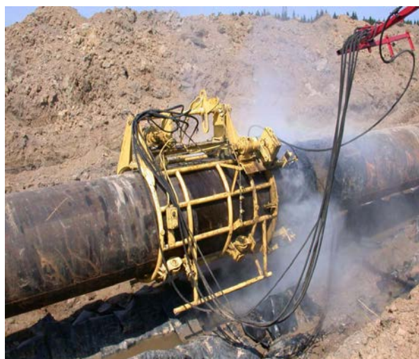
Рисунок 8 – Універсальна самохідна машина для видалення старої ізоляції
