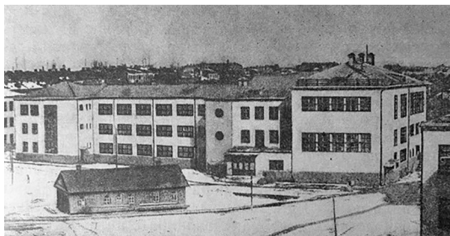
Рис. 1. Здание анатомического корпуса (1930 г.) [1, с. 20]
