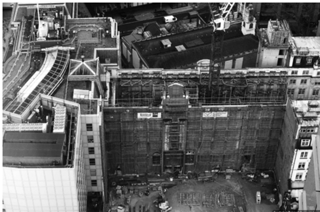
Рис. 1. Розміщення крану в габаритах будівлі під час реконструкції будівлі в історичному центрі м. Лондон
