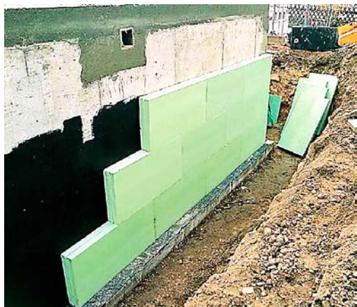
Рис. 3. Утепление с помощью плит пенопласта
