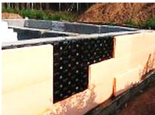
Рис. 4. Утепление с помощью плит Пеноплекса
