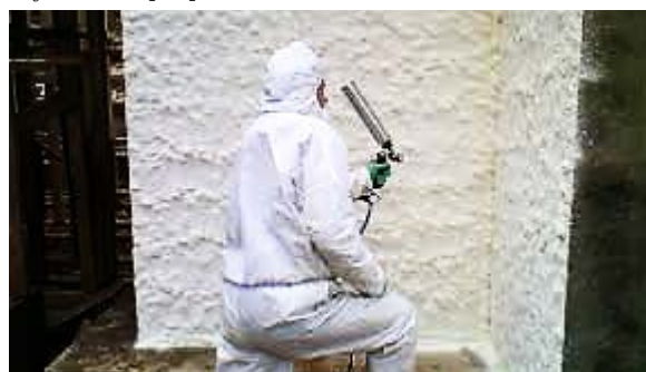
Рис. 8. Распыление на поверхность пенополиуретана
