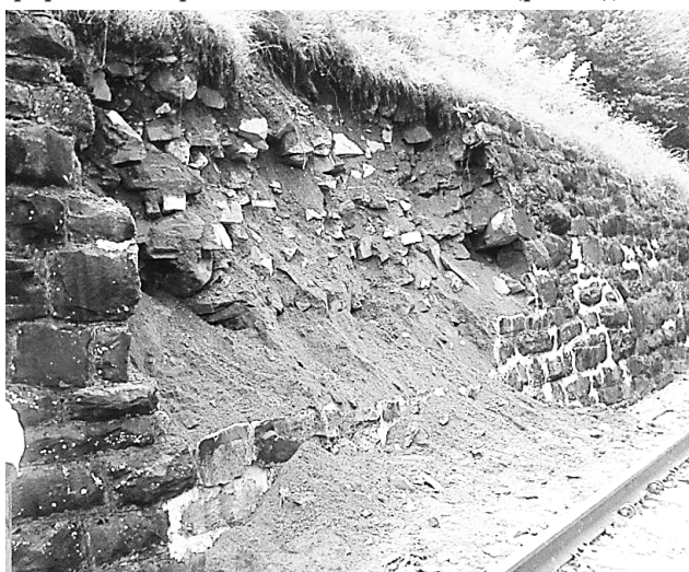
Рис. 5. Руйнування сухої кам'яної кладки і лотка верхової підпірної стінки
