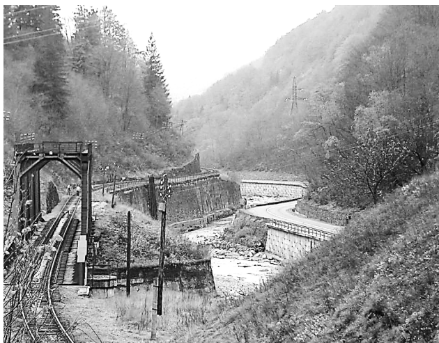
Рис. 4. Фото частини небезпечної ділянки
