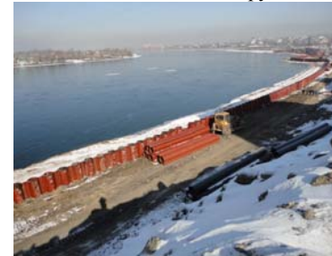
Рис. 1. Применение стального шпунта трубчатого профиля в ограждении речной набережной (Российская Федерация)
