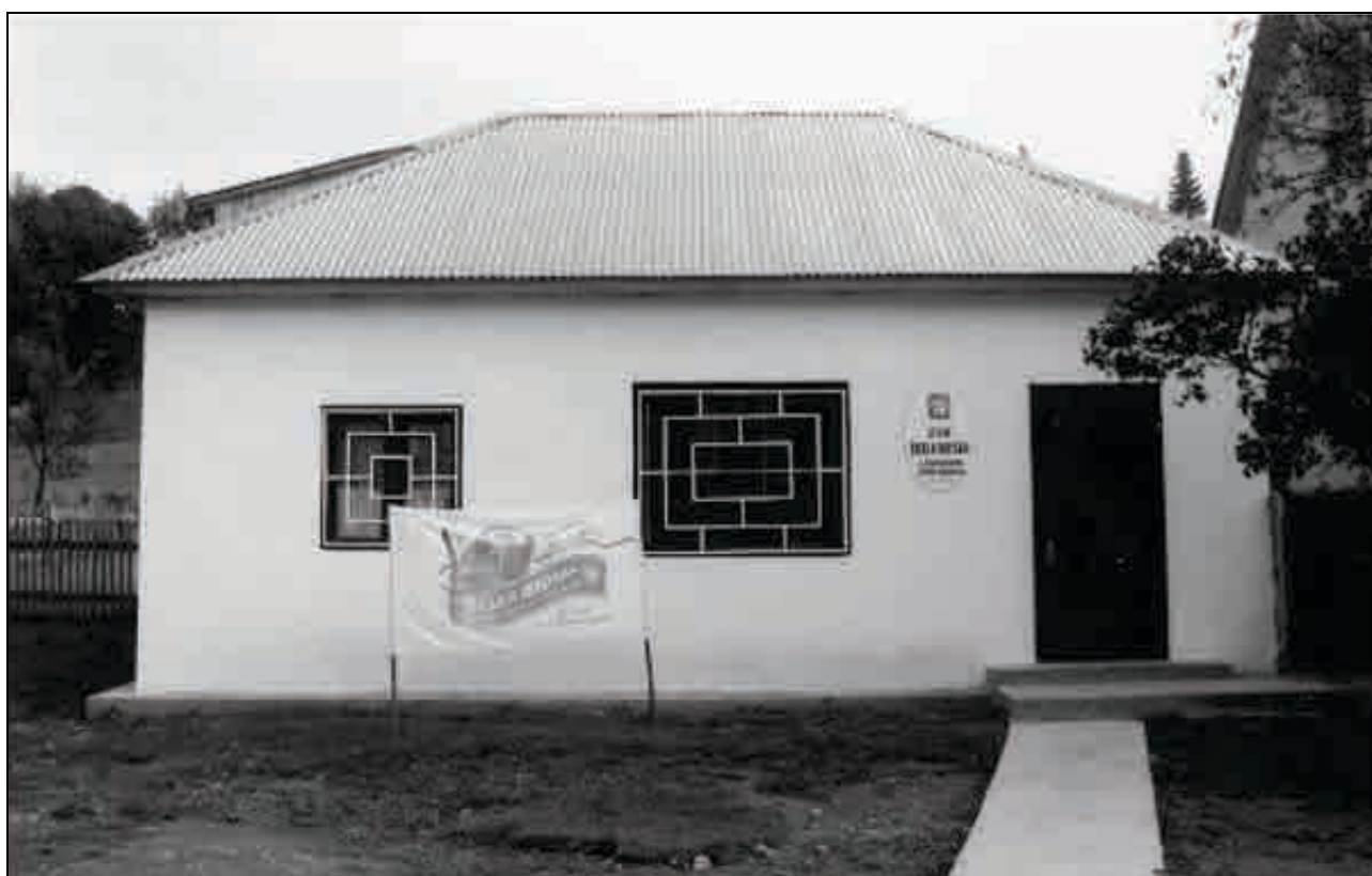
Budova muzejní Obecné školy v Koločavě
