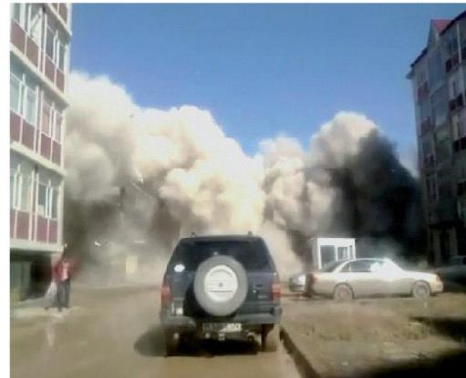
**Рис. 2.** Обрушение 5 этажного жилого дома в г. Караганде (Казахстан) вследствие развития сверхнормативного крена (отклонение здания от вертикали на момент аварии составило более 850мм).
