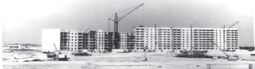
Рис.1. Будівництво житлових будинків на просідаючих ґрунтах, що підготовлені гідробуухом (виконано розробку проекту і моніторинг підготовки основи)
