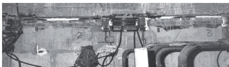
Рис.9. Установка дномкратої системи в підвальному просторі будинку, можна бачити щілину, що виникла між фундаментом і частиною верхньої будови, що піднімається, вкладили.
