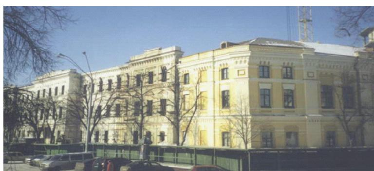
Рис.10. Будинок Дипломатичної Академії МЗС України після виправлення його просторового положення (деформації виправлені, більший кут підняття на 23 см.).
