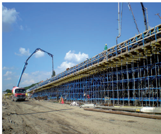
Рис. 1. Бетонування автомобільної естакади (віадук) термінального комплексу «D» ДМА «Бориспіль»
