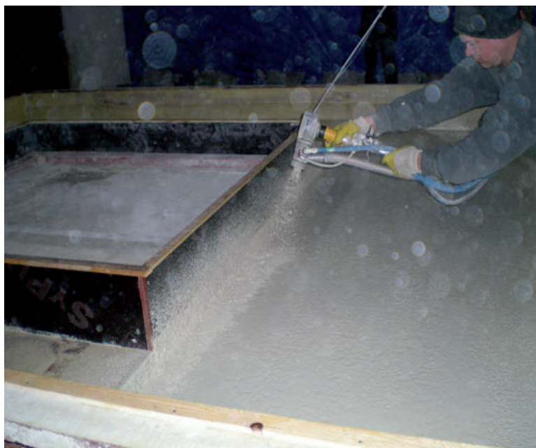
Рис. 2. Технологія виготовлення склофіробетонних шкаралуп панелей фірмою «АФБ АСПЕКТ»
