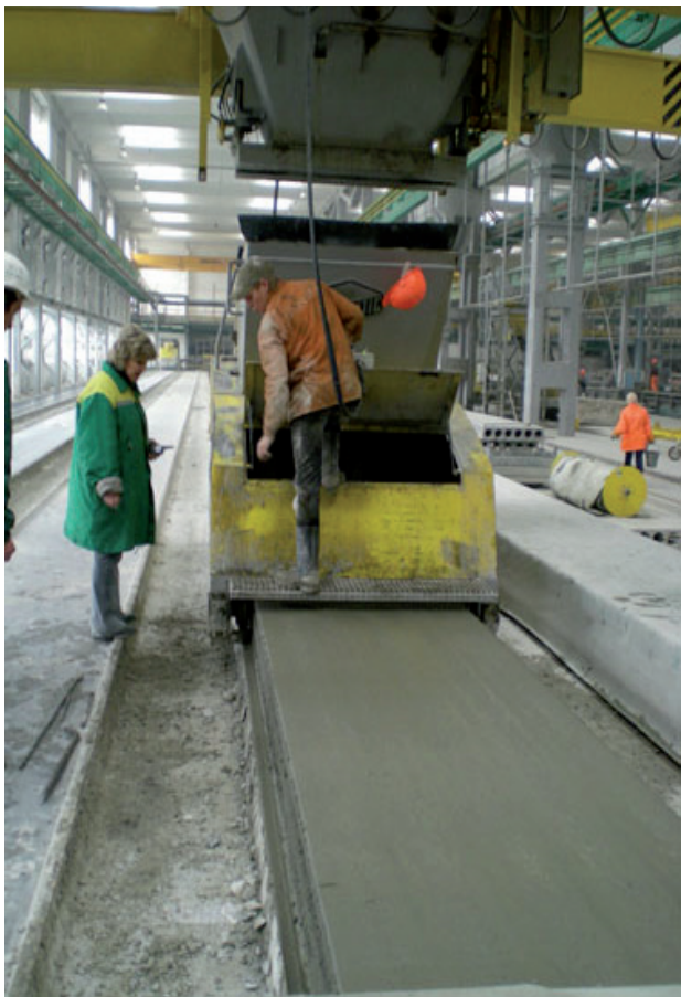
Рис. 5. Виробництво залізобетонних панелей по екструзійній технології на Севастопольському заводі ЗБК
