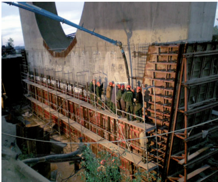
Рис. 6. Бетонування пошкодженої опори мостового переходу через р. Дніпро в м. Києві
