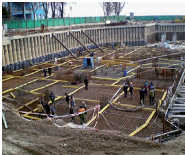
Рис. 3, 4. Технологія бетонування масивного ростверку для будинку по вул. Івана Мазепи м. Києва
