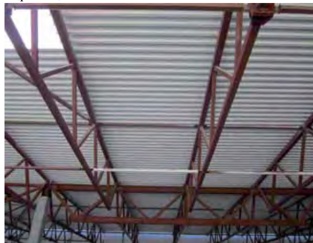
Рис. 1. Фрагмент покриття будівлі ТРЦ «Лавіна» по вул. Берковецькій, 6 у Святошинському районі м. Києва з профільованим металевим листом.
