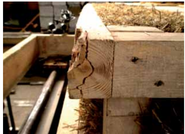
Рис.4. Дефекти панелі перекриття ПП-2
