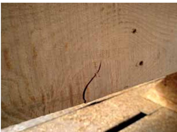
Рис.4. Дефекти панелі перекриття ПП-2
