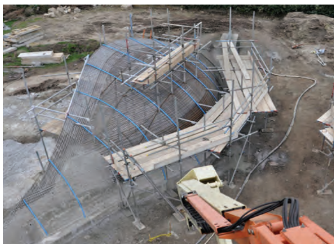
Рис.1. Современные технологии возведения криволинейных конструкций: а – несъемная опалубка из водостойкой фанеры [11]; б – изогнутые стены музея [11]; в) – арматурный каркас для акустических оболочек [12]; г – изготовление опалубки из пенополистирола [13]
