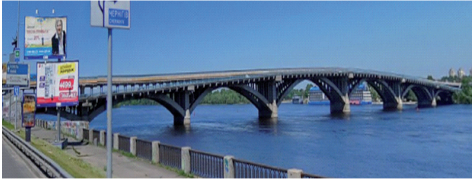
Рис.2. Міст Метро через р. Дніпро в м. Києві.
