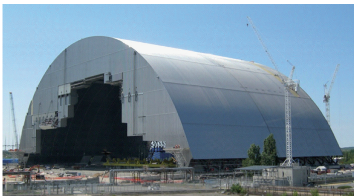
Рис.1. Спорудження Нового безпечного конфайнменту для об'єкта «Укриття» Чорнобильської АЕС.
