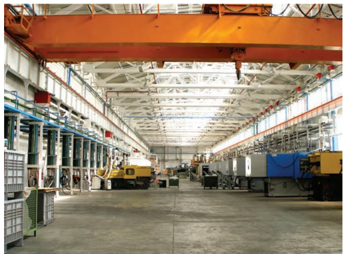
Рис.3. Загальний вид блоку в осях „Б-А”/„6-32”, після реконструкції
