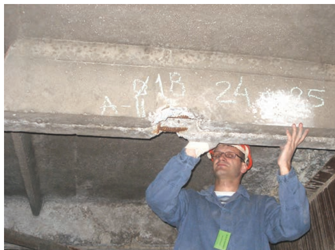
Рис.5. В процесі визначення технічного стану плит покриття сумішеного даху виробничого корпусу.
