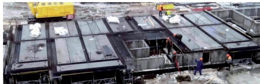
**Рис.6.** Влаштування збірно-монолітного перекриття з пустотними попередньо напруженими плитами та прихованими ригелями
