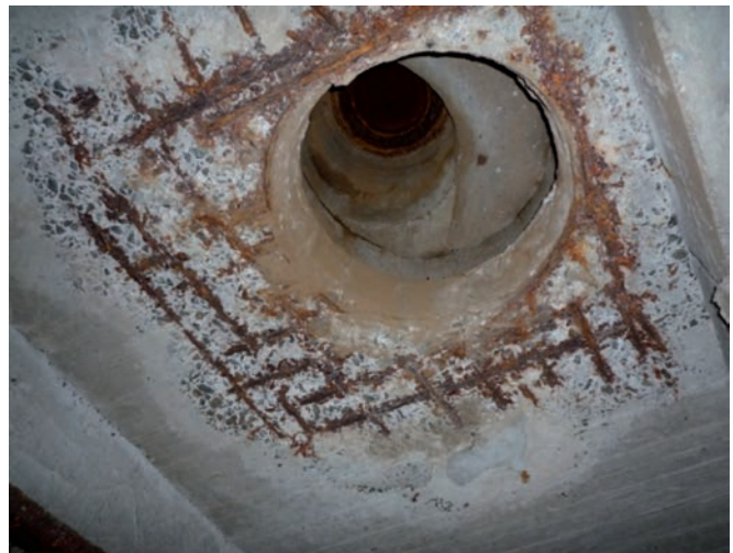
Рис. 5. Зруйнований захисний шар бетону з оголенням і корозією арматури плит перекриття навколо люків
