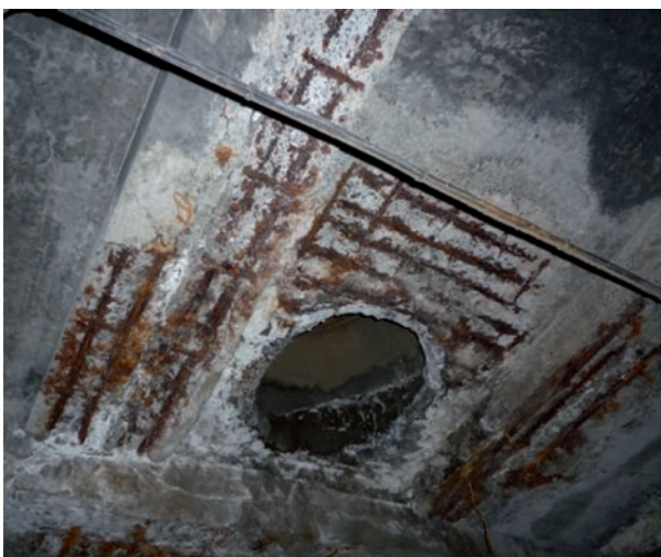
Рис. 5. Зруйнований захисний шар бетону з оголенням і корозією арматури плит перекриття навколо люків
