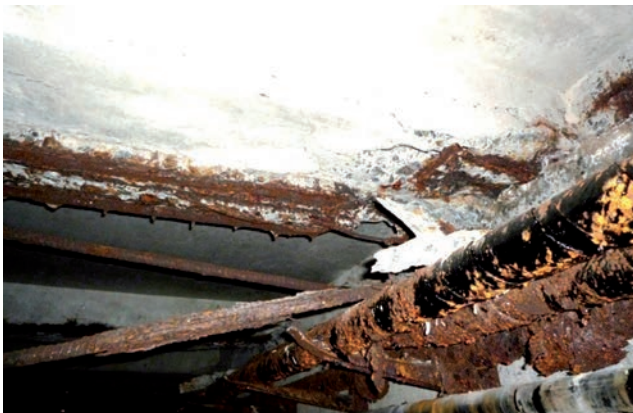
Рис. 8. Плити перекриття колектора з корозійними пошкодженнями і відокремленням частини арматури
