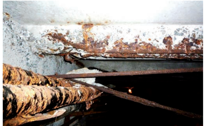
Рис. 8. Плити перекриття колектора з корозійними пошкодженнями і відокремленням частини арматури
