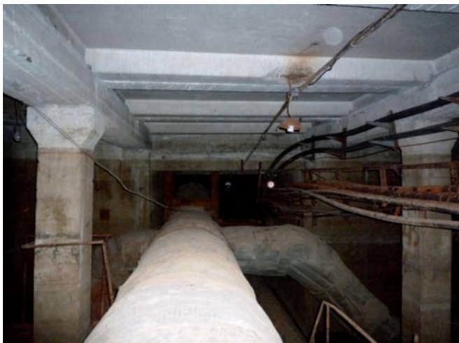
Рис. 3. Внутрішні види колектора з трубопроводами тепло- і водопостачання та різноманітними електричними кабелями
