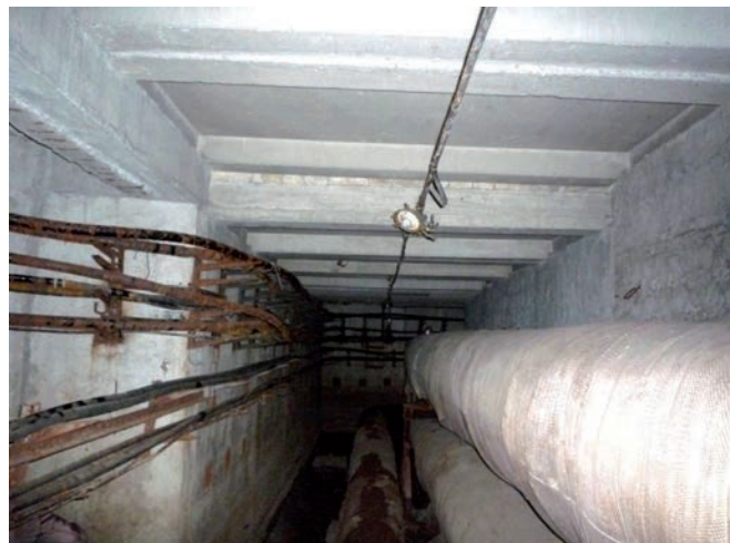
Рис. 3. Внутрішні види колектора з трубопроводами тепло- і водопостачання та різноманітними електричними кабелями
