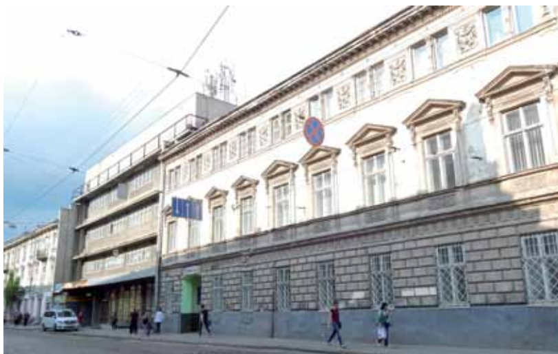
Рис. 1. Група з трьох будинків №№: 21, 23-А, 25 (зліва - направо) по вул. Івана Франка у м. Львові. Будинок № 23-А побудований на місці зруйнованого будинку
