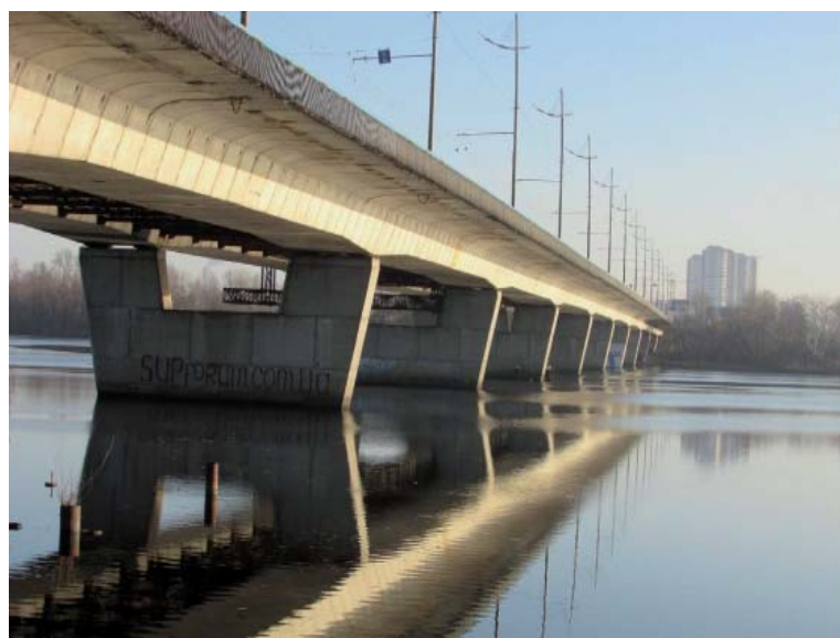
Рис. 1. Загальний вигляд мосту (вид з правого берега)
