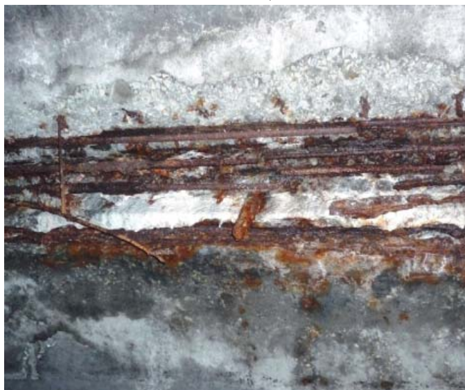
Рис. 13. Значне зменшення перерізу з розривом поздовжніх арматурних стержнів у плиті довжиною 15 м настилу правобережної кінцевої ділянки внаслідок корозії
