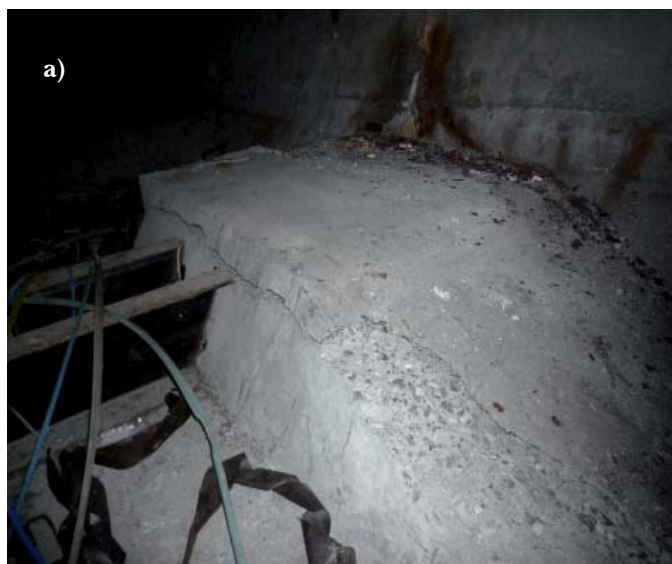
Рис. 7. Силкові (а) та корозійні (б) пошкодження вузлів анкерування напружених арматурних пучків нижньої плити коробчастих балок
