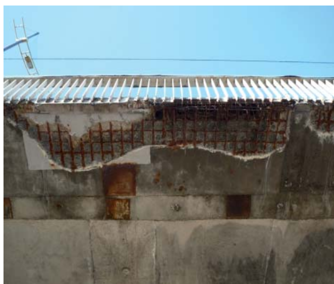
Рис. 6. Пошкодження тротуарних плит (вид знизу)
