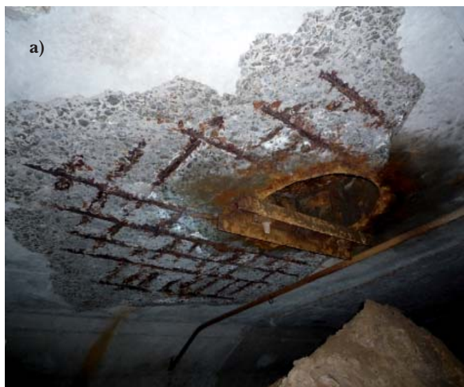
Рис. 5. Руйнування захисного шару бетону, оголення і корозія арматури верхньої (а) та нижньої (б) плит коробчастої балки
