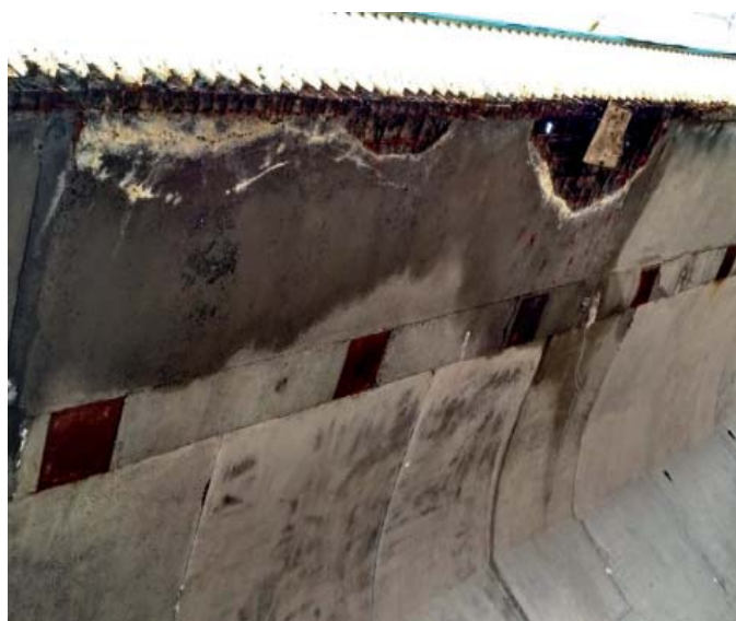
Рис. 6. Пошкодження тротуарних плит (вид знизу)
