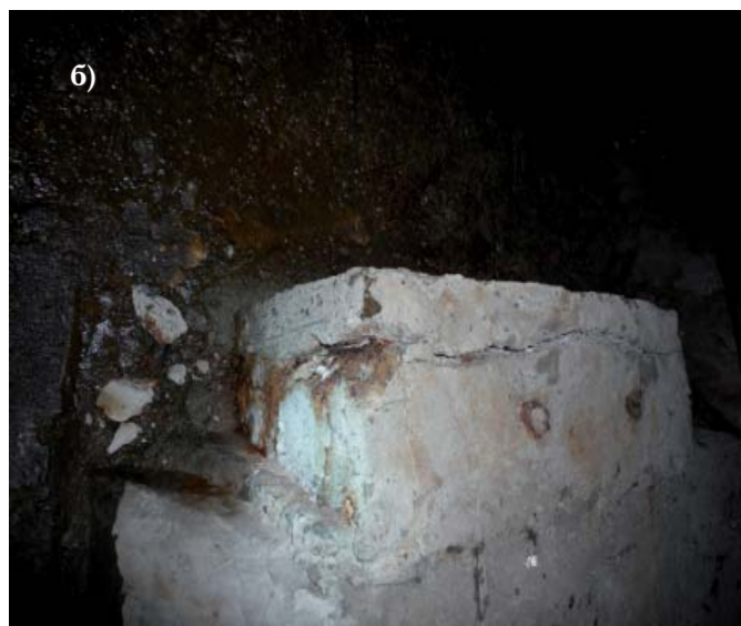
Рис. 7. Силкові (а) та корозійні (б) пошкодження вузлів анкерування напружених арматурних пучків нижньої плити коробчастих балок
