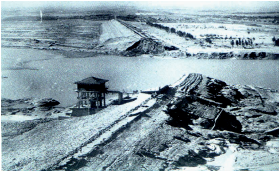
Рис. 2. Аварія на греблі Баньцяо, (Китай), 1975 р., висота греблі 118 м, загинуло біля 26 тис. людей, 145 тис. померло внаслідок голоду й епіdemій, зруйновано 5 960 000 будинків, постраждало майже 11 млн. осіб
