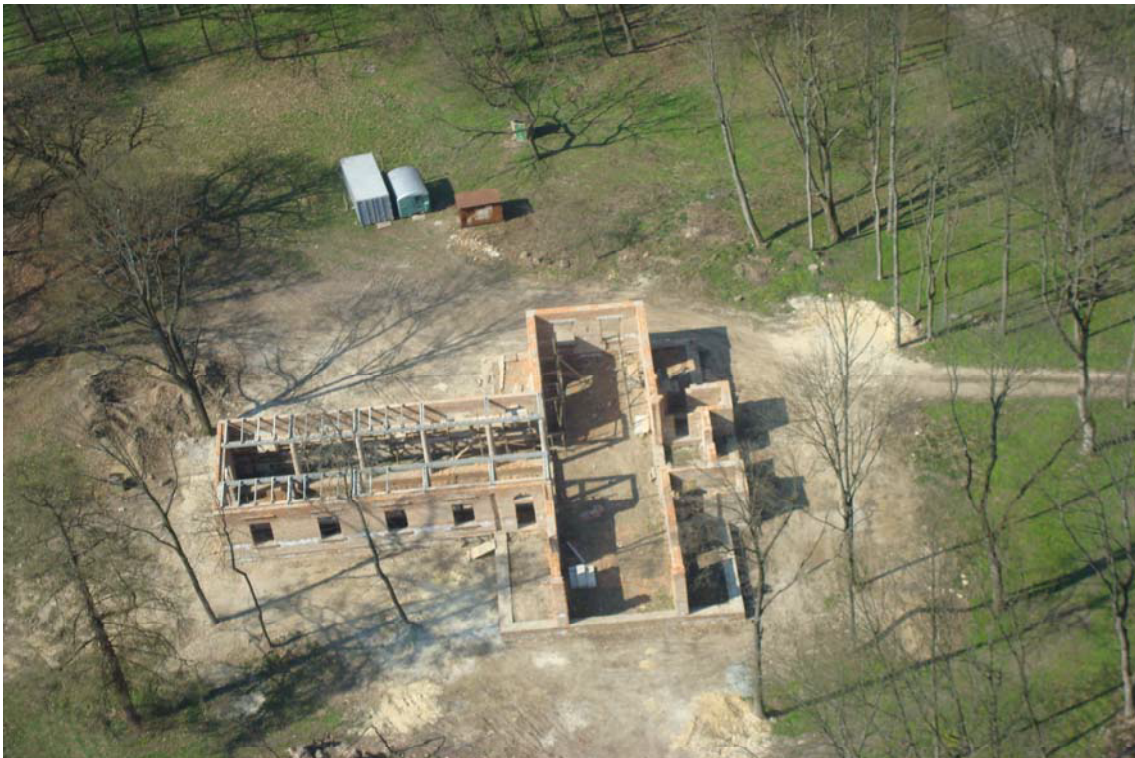
Рис. 2. Будівництво Танцювального павільйону (вигляд зверху, 2009 р.)
