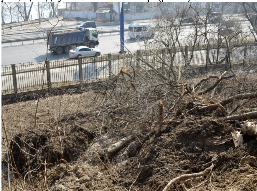
Рис. 1. Аварійний зсув ґрунту під ділянкою «Красний двір» (04.2013р.)
