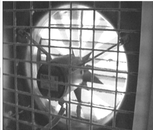
Рис. 10. Витяжні вентилятори у крільчатнику.
