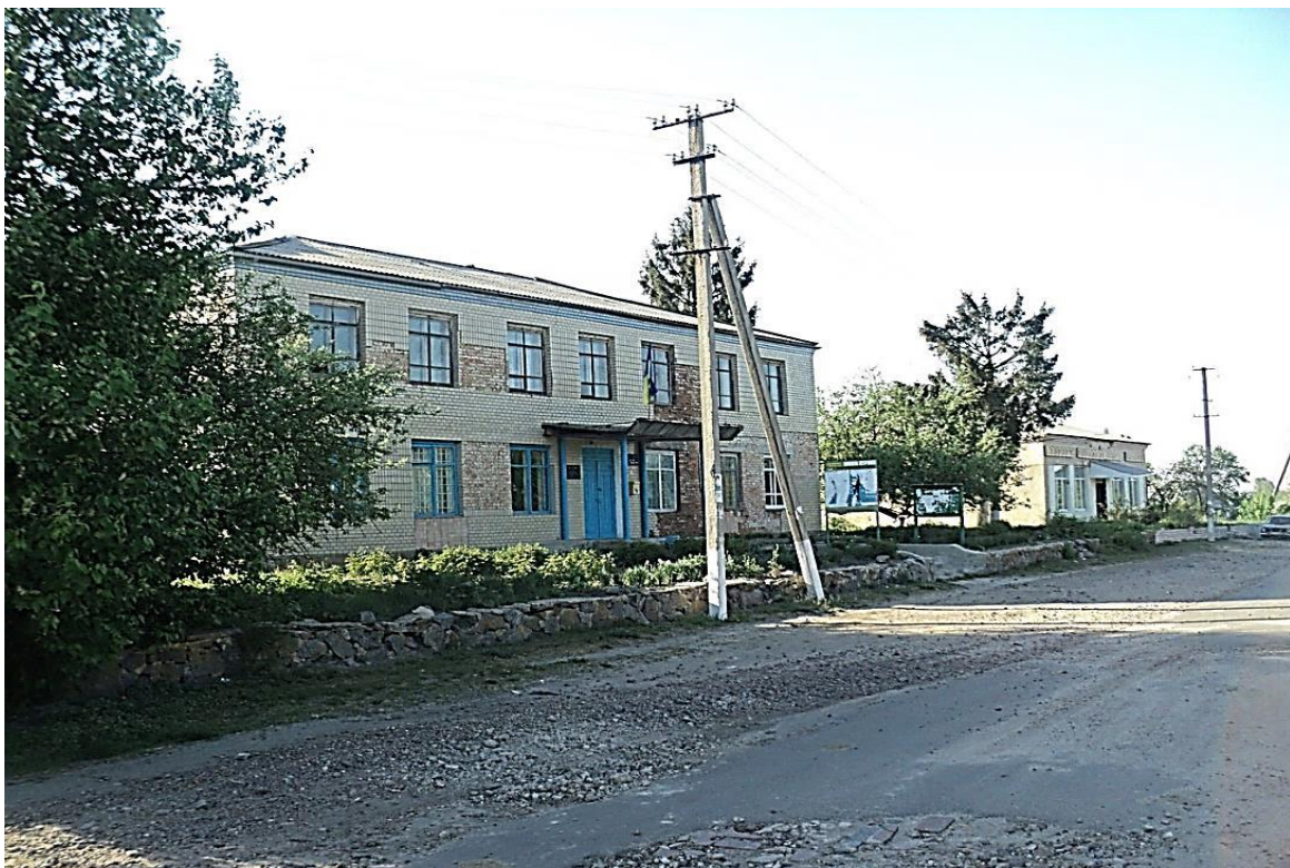
Рис. 2. Ділянка дороги по вулиці Сквирській у с. Березянка Ружинського району Житомирської області (зруйнований дорожній одяг).
